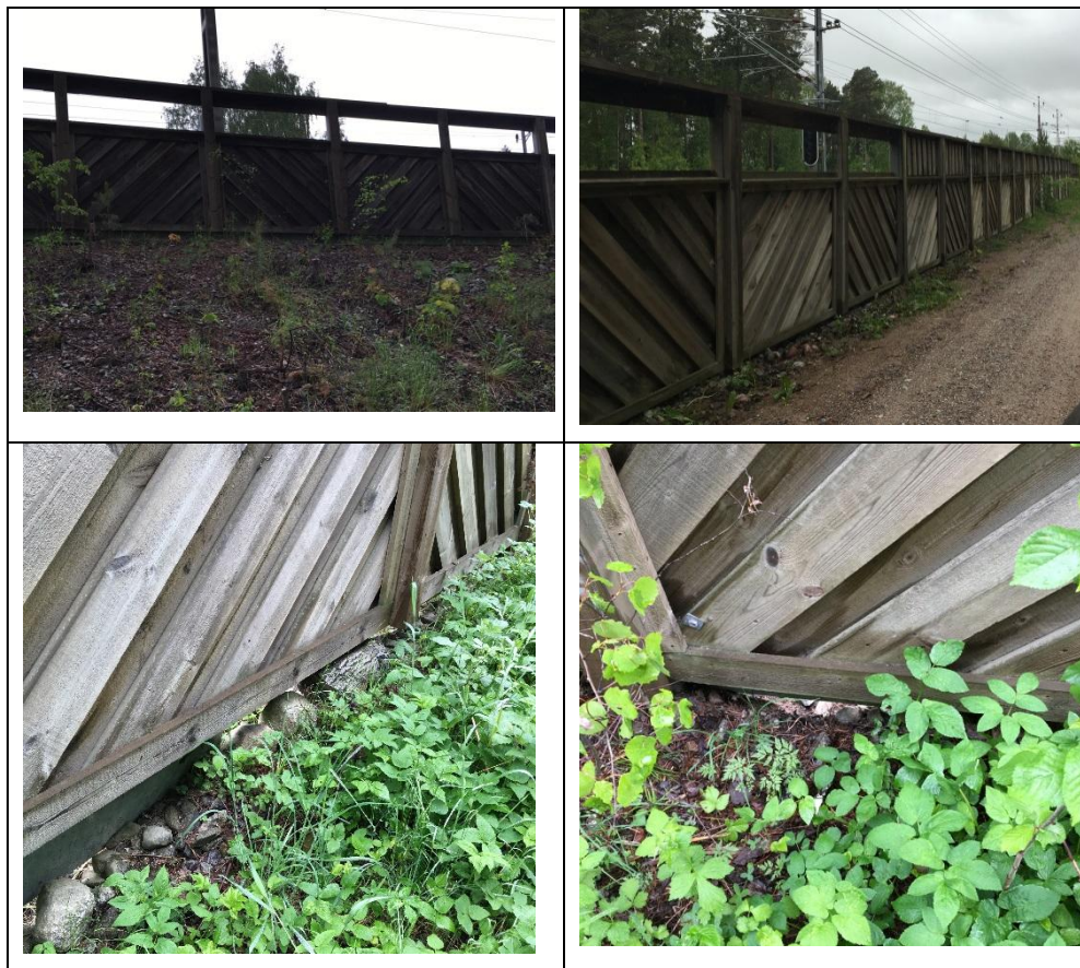
Bild 1. Befintligt bullerplank i fullhöjd 2,1 meter upp till överliggaren och i övrigt tätt upp till 1,6 meter över mark. Håligheter under plank.
