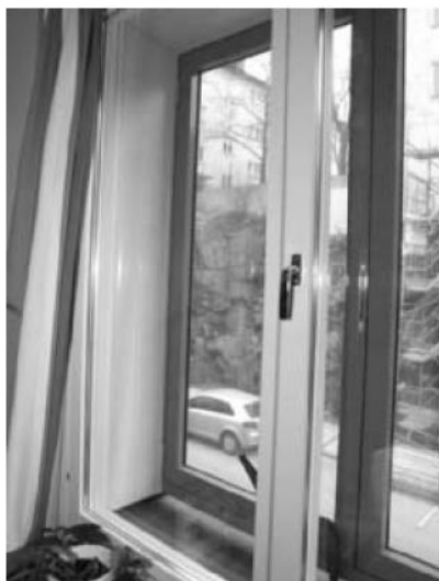
Bild 1. Exempel på specialfönster, hämtad från Trafikbuller i planeringen III, ISBN 10: 91-85125-20-2, Alfa Print 2006 Sundbyberg. Fönsteröppningen förses exempelvis med ett yttre glas med vädringsöppning och ljudabsorbent mellan fönstret och det yttre glaset.
